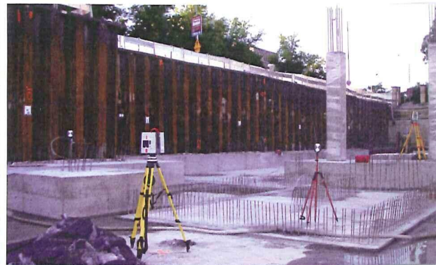
Na budowie centrum handlowego Galeria Kaskada w Szczecinie
